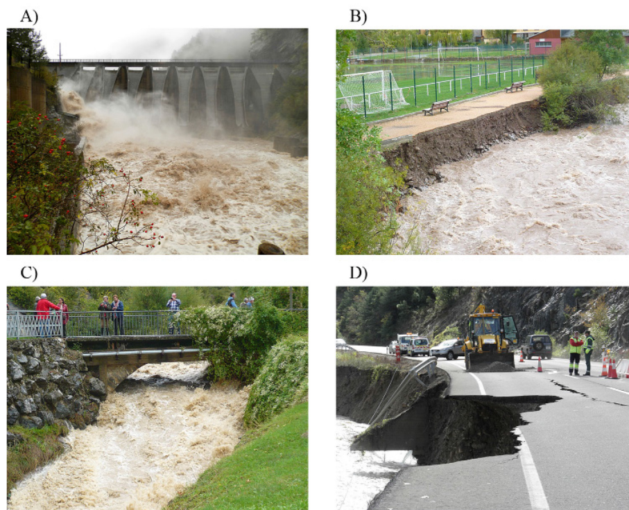
Figura 1 | Efectos de las inundaciones provocadas por las precipitaciones extremas registradas en Octubre de 2012 en la tramo alto del río Aragón: A) Presa de Canfranc; B) Parque de la localidad de Villanúa; C) Barranco de Villanúa; D) Carretera N-330 en las proximidades de Villanúa.
